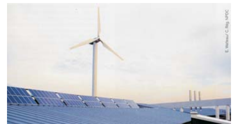
Lycée HQE de Calais, I. Colas et J.C. Louis architectes
