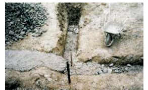
Fondations en béton, maison romaine
