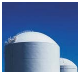
Biogaz : source d'énergie alternative
